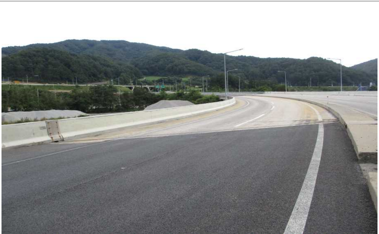
교량 상부 전경
